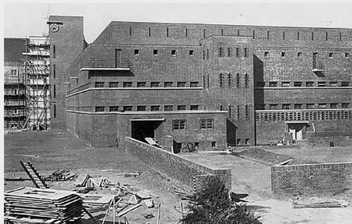
Carl-Duisberg-Gymnasium in Leverkusen im Bau, um 1928, Stadtarchiv Leverkusen
